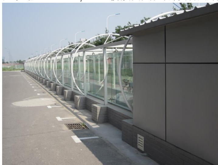
图 4.3 模拟舱舱体外部实物照片
